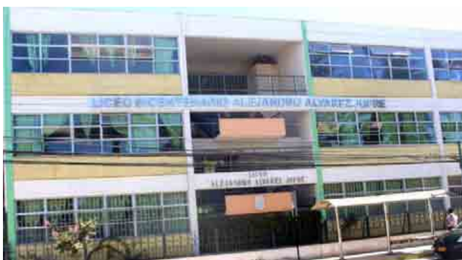
El Liceo Alejandro Álvarez Jofré, ubicado a un costado de la plaza de armas, será el centro de acopio en Ovalle.
