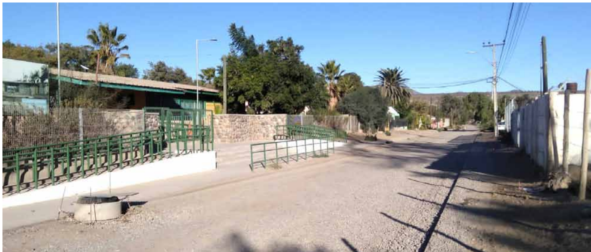
La calle en donde se ubica la escuela de Recoleta no podrá ser pavimentada hasta que no se dé solución al proyecto de alcantarillado.
