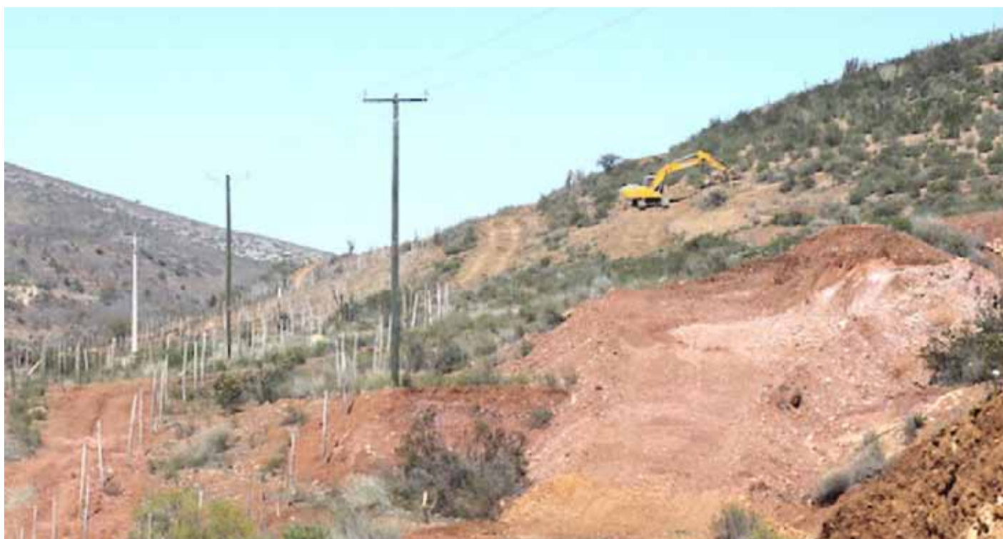
En Potrerillos Alto existe preocupación por los caminos y el puente del sector.
