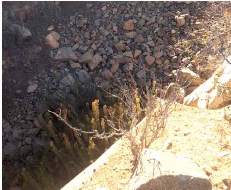
Rocas y escombros obstaculizan el canal Recoleta, y por eso hay temor de un inminente colapso por las lluvias.
