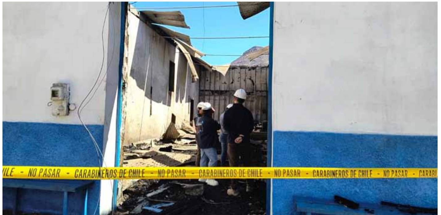
Autoridades visitaron la capilla incendiada en Pichasca, realizando una primera evaluación de los daños.
