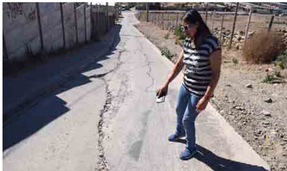
El pavimento se ha ido agrietando cada vez más, provocando un riesgo inminente de derrumbe.
