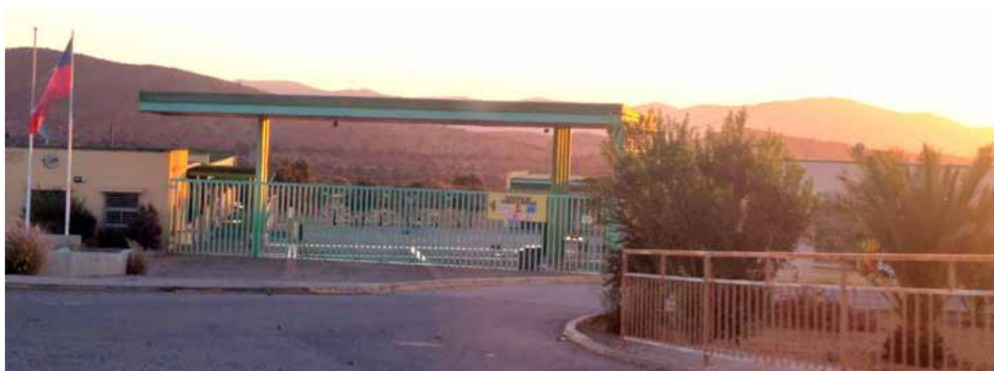
La Escuela Teresita de Los Andes se encuentra ubicada en el sector de Las Ramadas de Punitaqui.
