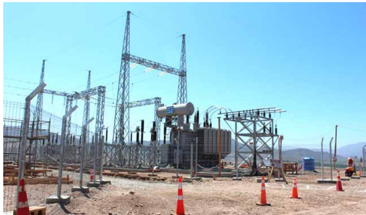
La iniciativa contempla la construcción de 88 torres de alta tensión.
