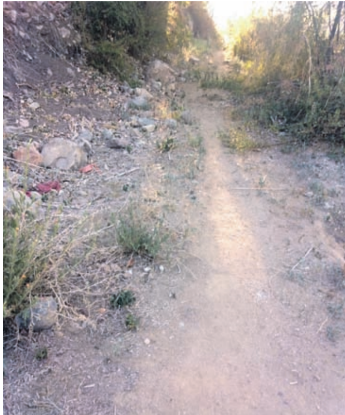
Canal de El Maqui Bajo luego del entubamiento del canal.
