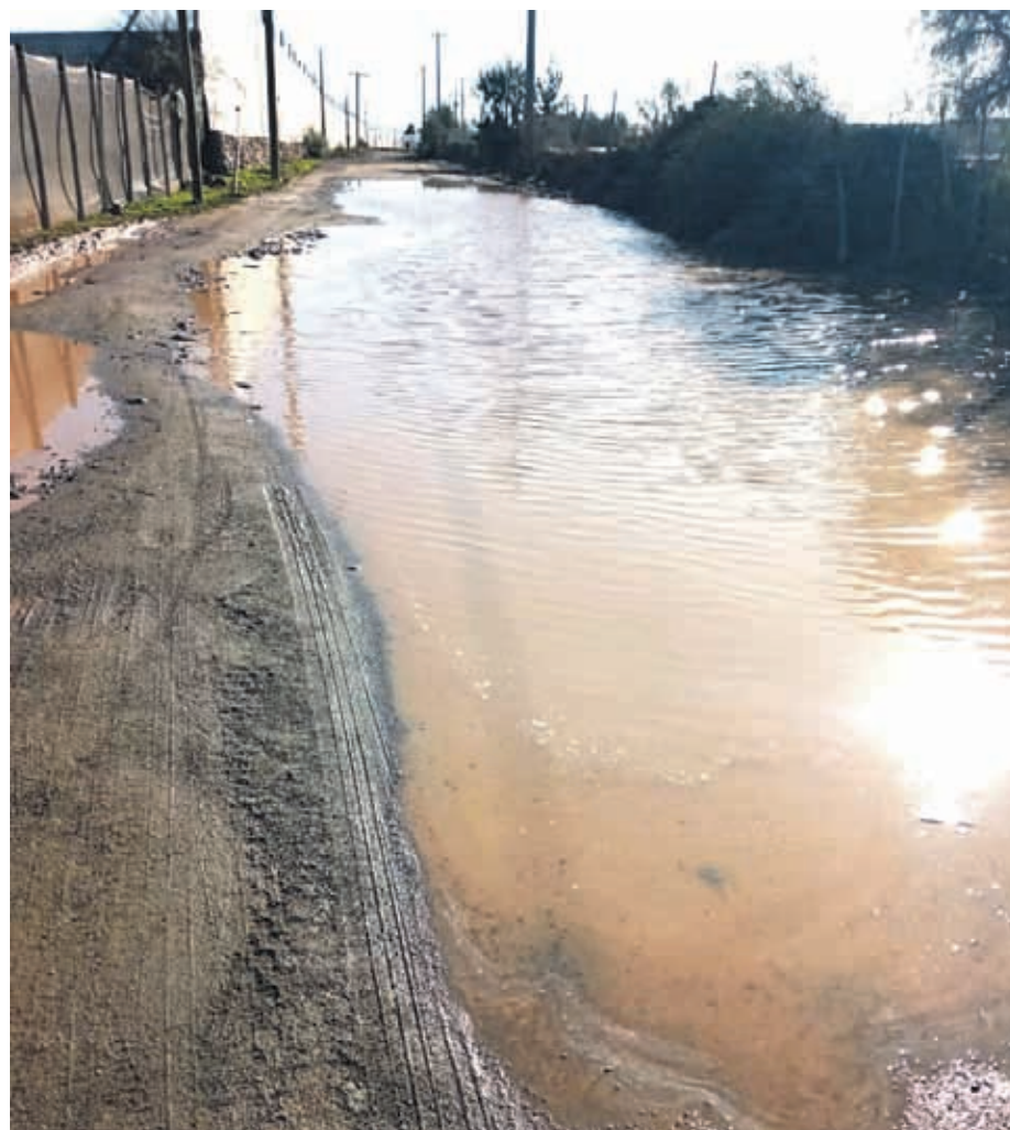
El camino de acceso a la Villa Esperanza en el Pueblo Limarí registra un estado deplorable luego de las últimas lluvias.
